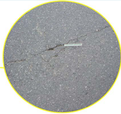
Foto B-1 – Trinca isolada
