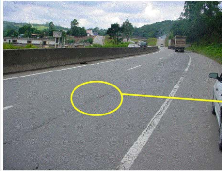
Foto B-1 – Trinca isolada
