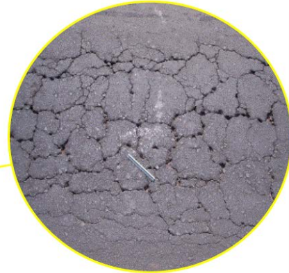
Foto B-2 – Trincas interligadas do tipo couro de jacaré
