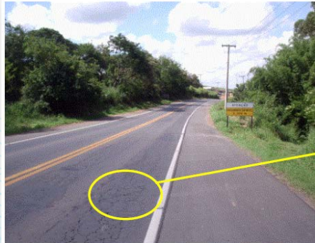
Foto B-2 – Trincas interligadas do tipo couro de jacaré
