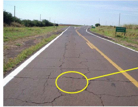
Foto B-3 – Trincas interligadas em bloco
