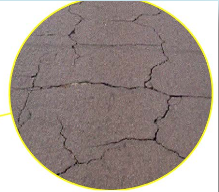
Foto B-3 – Trincas interligadas em bloco
