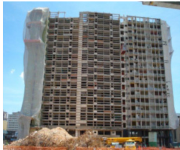
Figura 4 - Demolição dos Edifícios São Vito e Mercúrio
