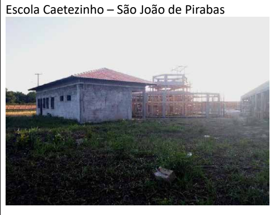
Figura 7 - Obras em execução vistoriadas pelo aplicativo “Tá de Pé” em novembro/2017
