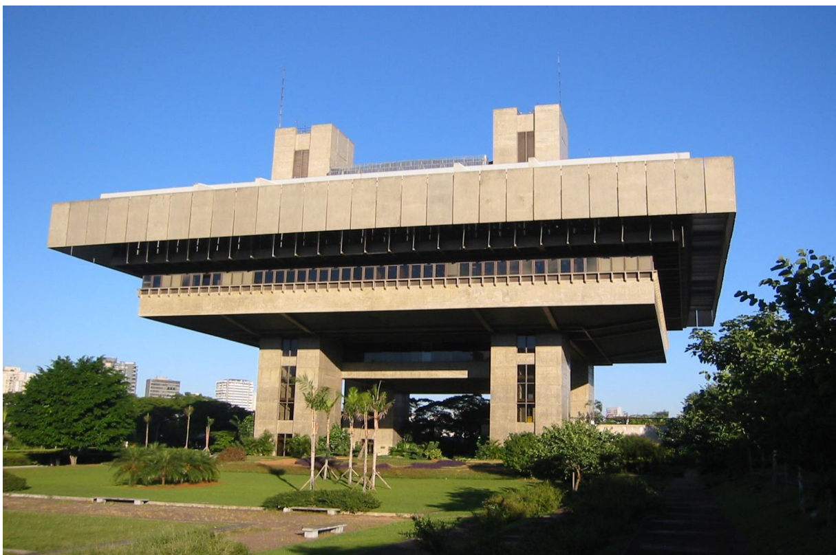
Foto 1: Visão geral do prédio
